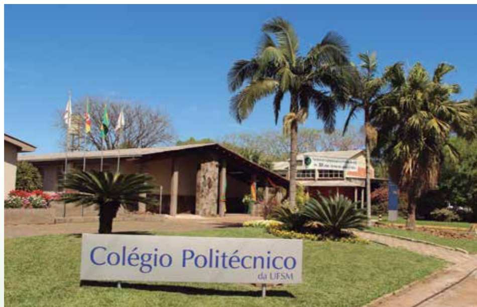
Vista parcial do prédio do Colégio Politécnico da UFSM
